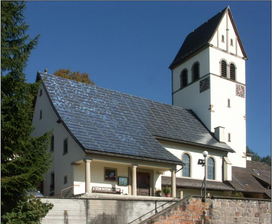
Bergkirche mit Solaranlage. © H. Mahler
