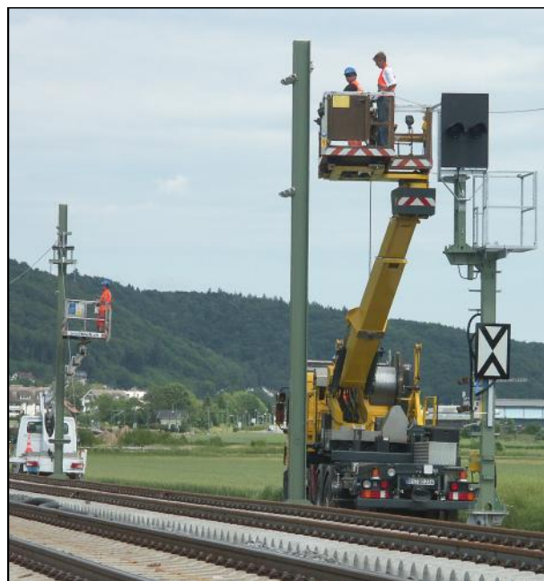
Juni 2013: Gleisbau und Elektrifizierung verlaufen parallel.
